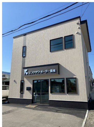
本社工屋外観
