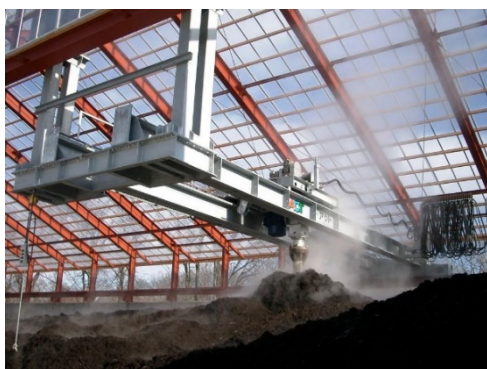
【堆肥攪拌装置】
