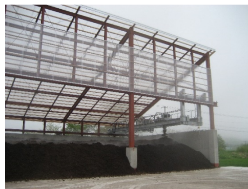
【堆肥攪拌装置】
